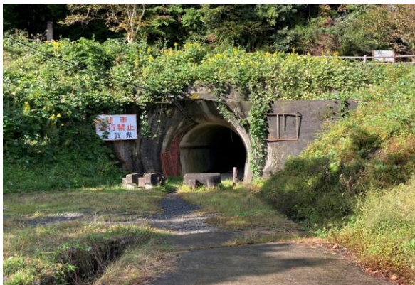
PhotoControl-1 西野水道 link この写真の右手にある休憩所でも可。 洪水対策で岩山を掘り抜いた琵琶湖への排水路。
