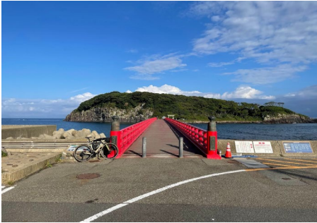
フォトコントロール1 雄島橋
