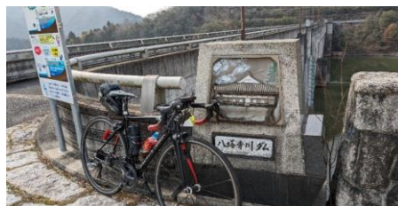
通過チェック1 八塔寺川ダム
